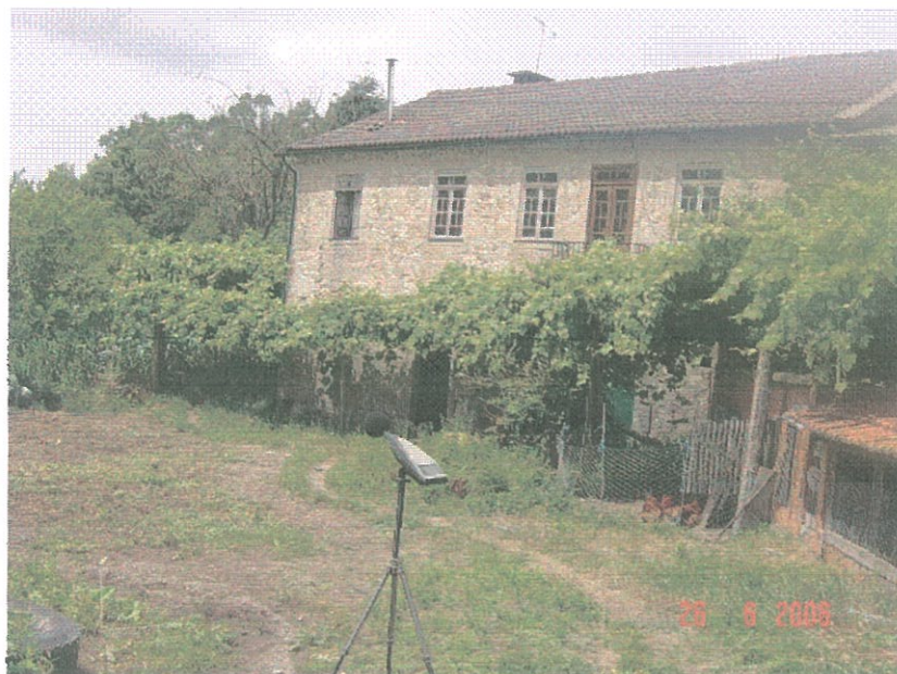
Figura 19 – Pk 51+375, lado esquerdo, povoação de Entre Águas, habitação a 150m da via
