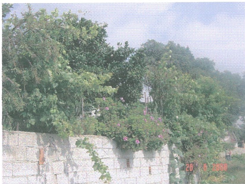
Figura 11 – Pk 38+225, lado direito, povoação de Moitedo, habitação junto da igreja a 100m da via
