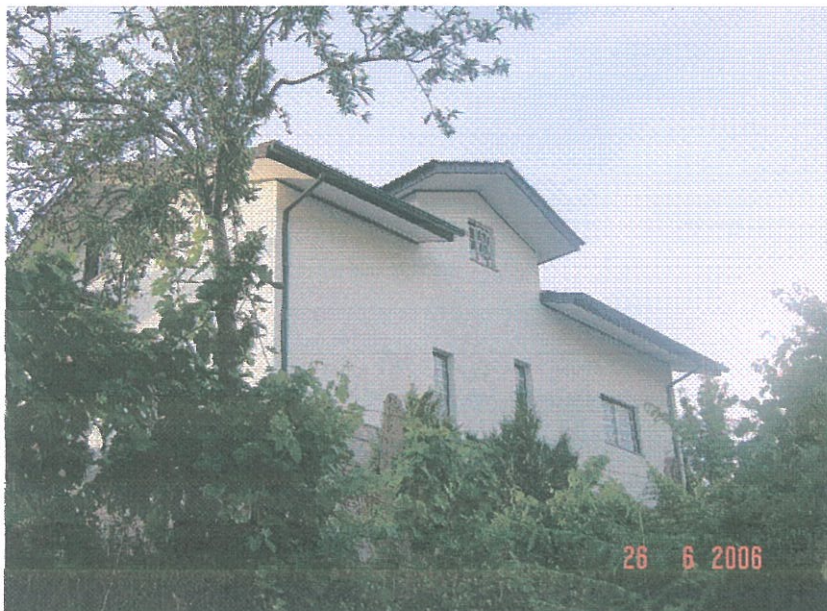
Figura 28 – Pk 61+925, lado esquerdo, povoação Confulcos, a 40m da via, próximo do Nó de Vozela
