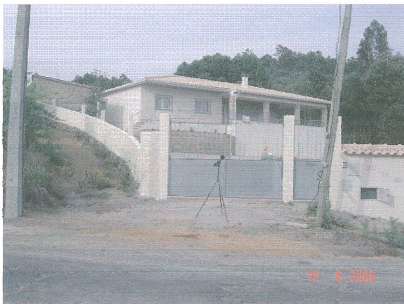
Figura 26 – Pk 60+625, lado esquerdo, povoação de Cambra, a 80 m da via
