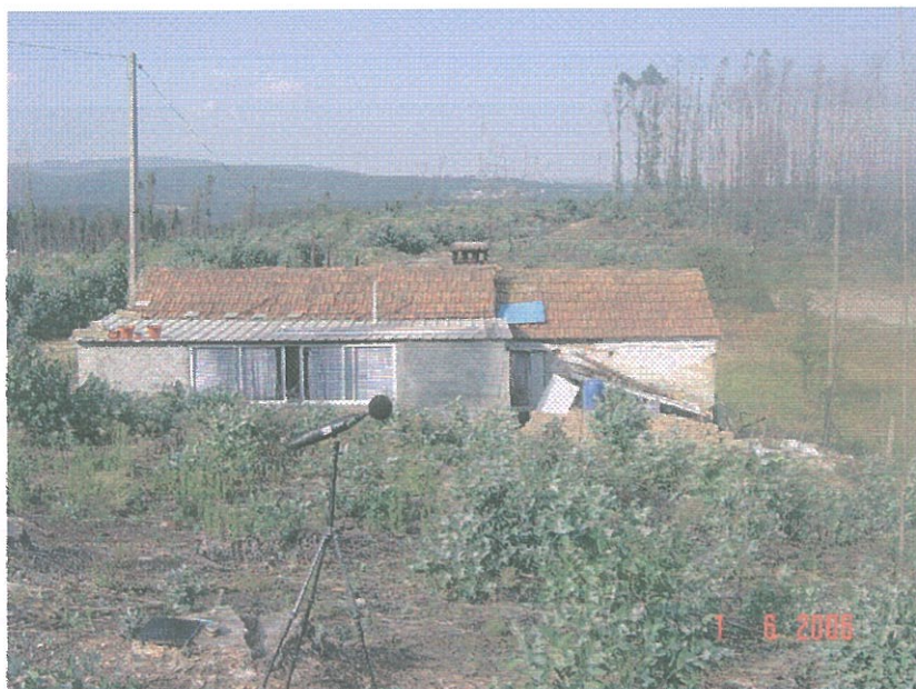
Figura 3 – PK 29+825, lado esquerdo, habitação a 100 m da via
