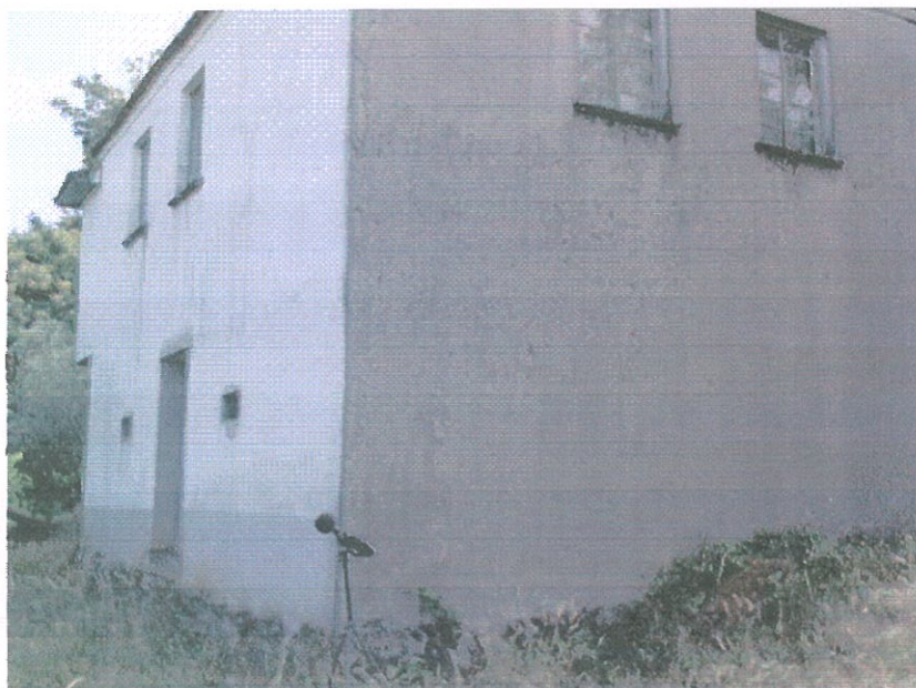
Figura 31 – Pk 67+763 - Km 5+400, lado sul
