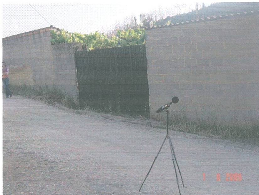
Figura 5 – Pk 31+575, lado direito, habitação a 100 m da via
