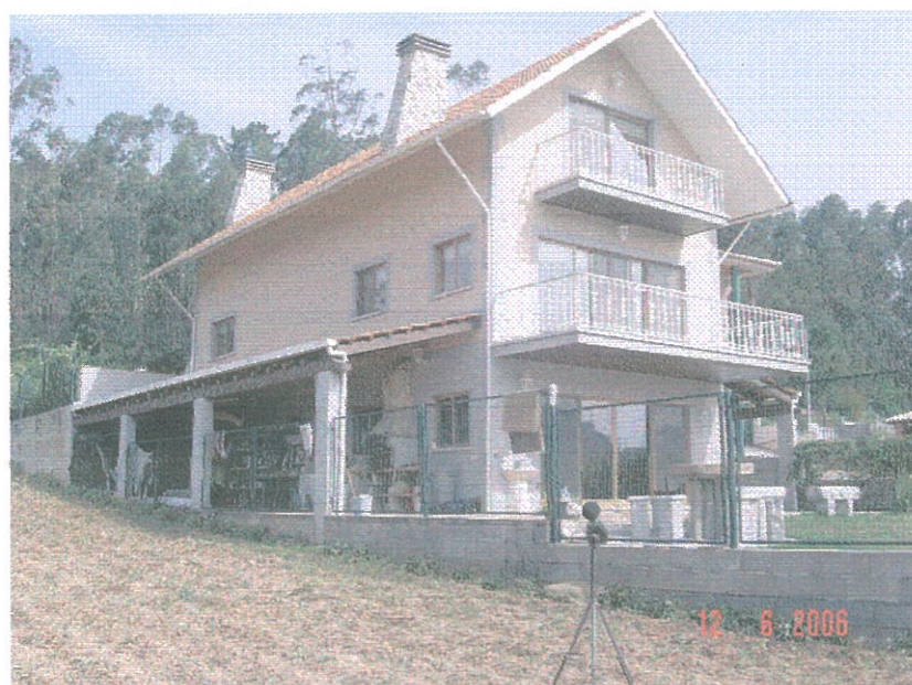
Figura 6 – Pk 32+125 lado esquerdo da via, Povoação de Carvoeiro a 250m da via
