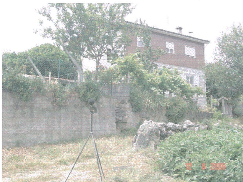
Figura 18 – Pk 50+375, lado esquerdo, habitação a 100m da via, junto ao nó do Reigoso
