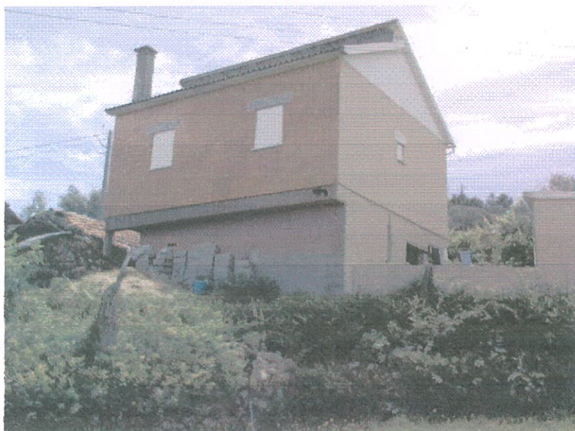
Figura 32 – Pk 68+013 - Km 5+650, lado Sul
