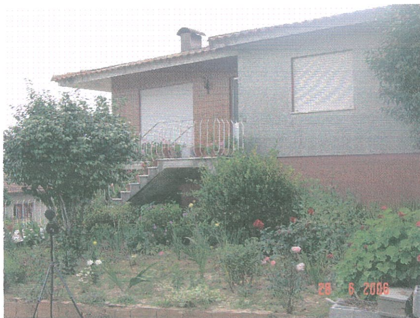
Figura 9 – Pk 33+425 lado direito da via, habitação junto à escola primária da Povoação de Salgueiro a 200m da via
